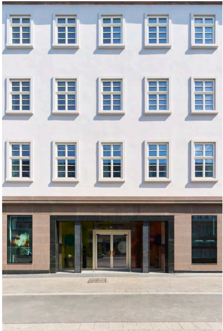
Fassade Herforder Straße 6
