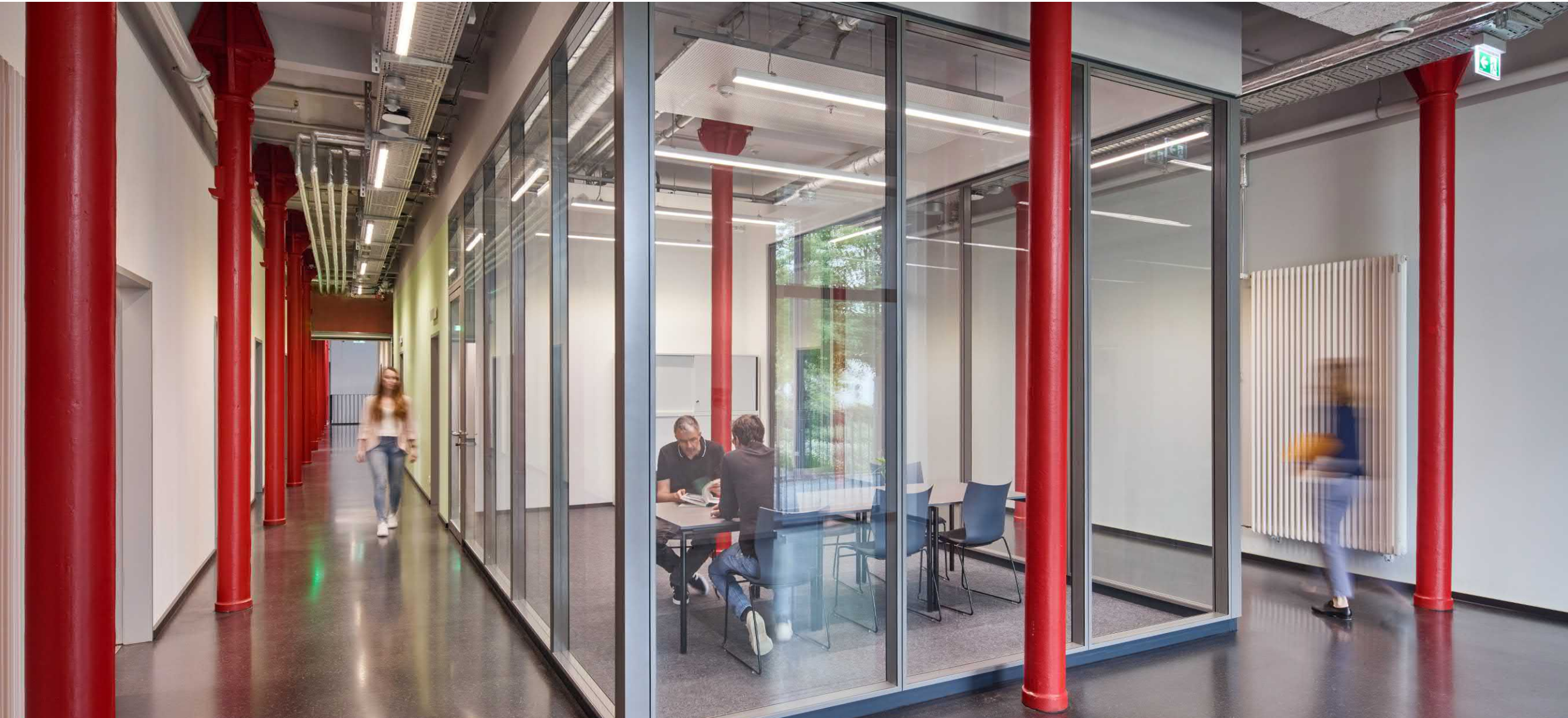
Den sanierten Bestand prägen weiterhin die alten, gusseisernen Rundstützen
