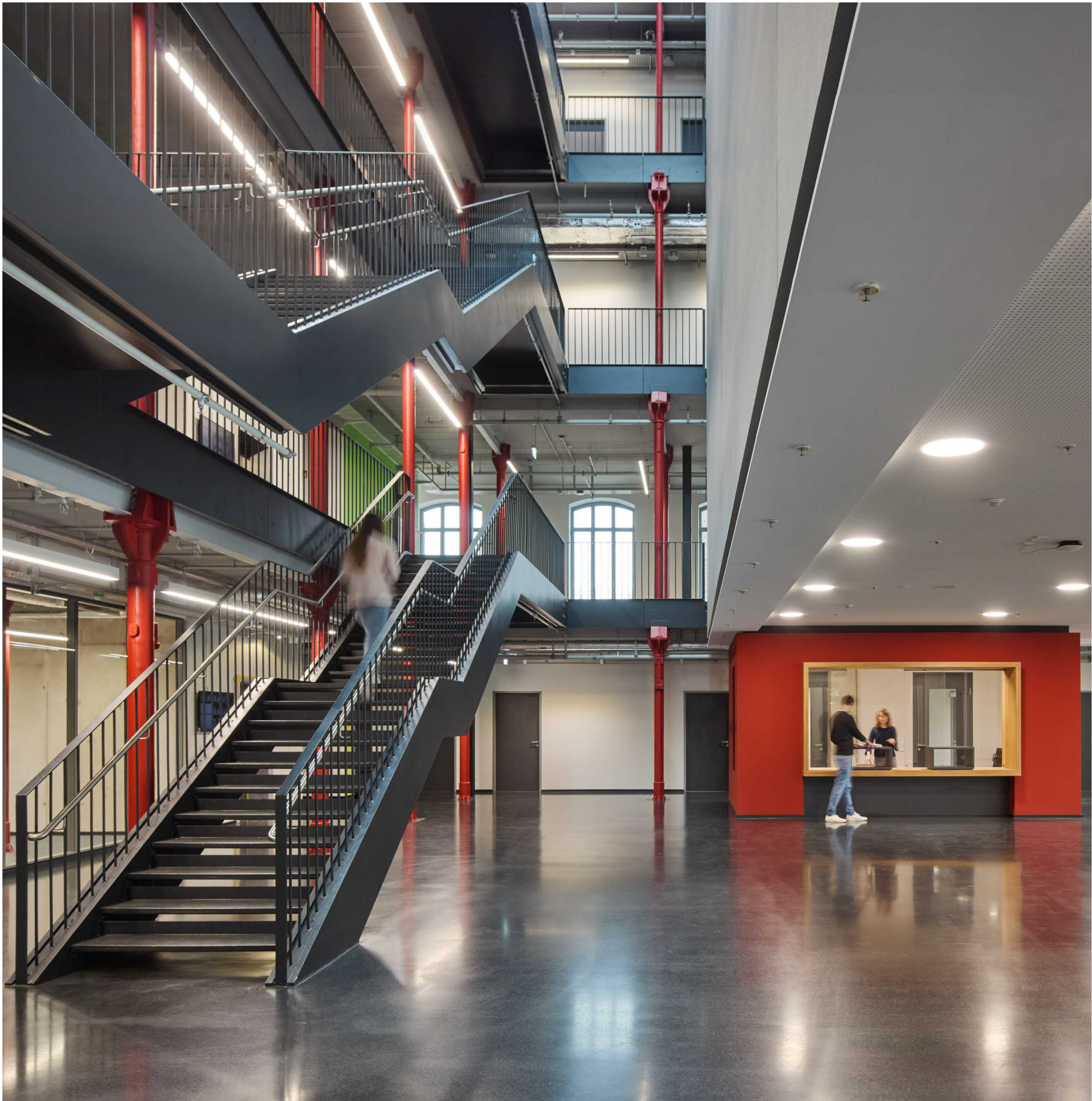
Die offene Haupttreppe mit seinem gebäudehohen Luftraum lässt die Verknüpfung aller Nutzungseinheiten erleben
