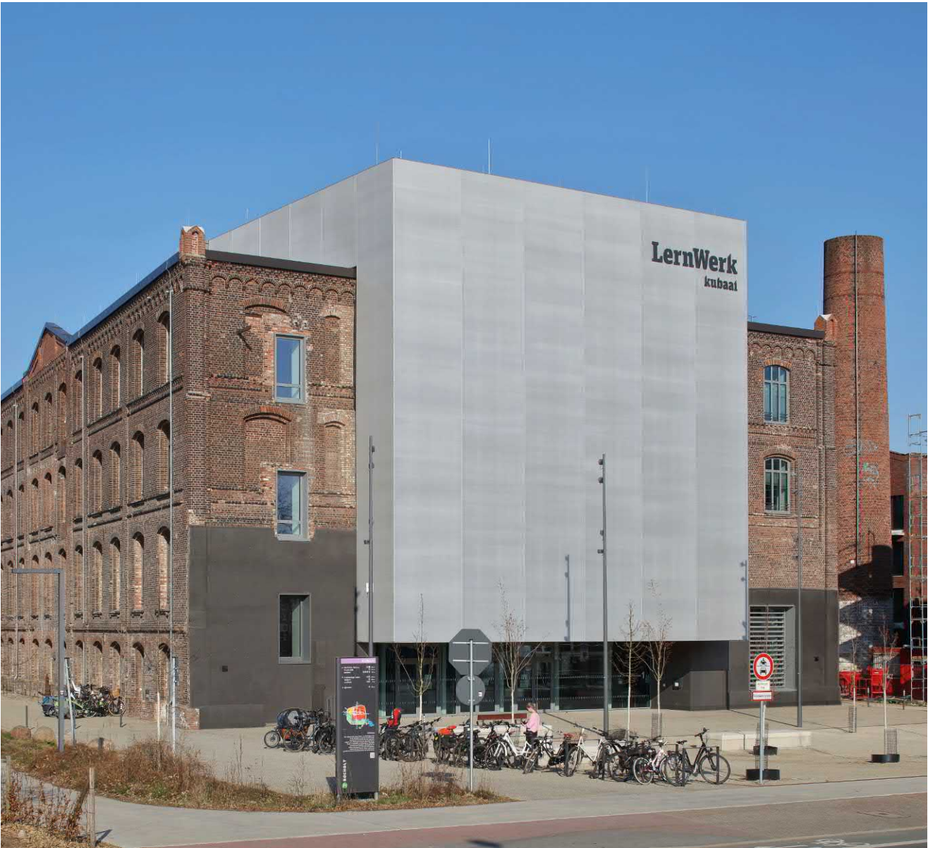
Der textile Einschub ist eine Hommage an die industrielle Vergangenheit
