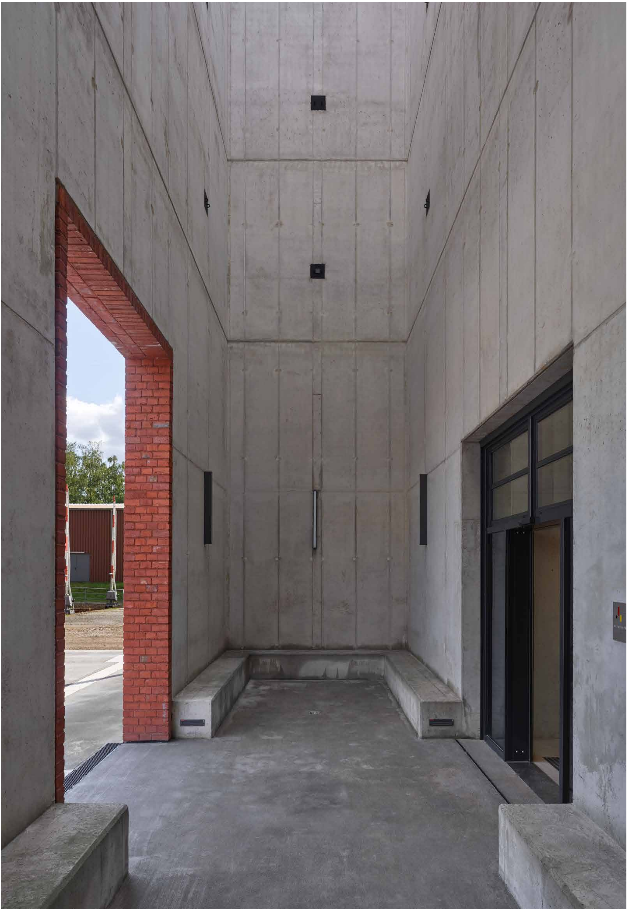
Der nach oben offene Vorraum wird zum eindrücklichen Auftakt des Empfangsgebäudes.
