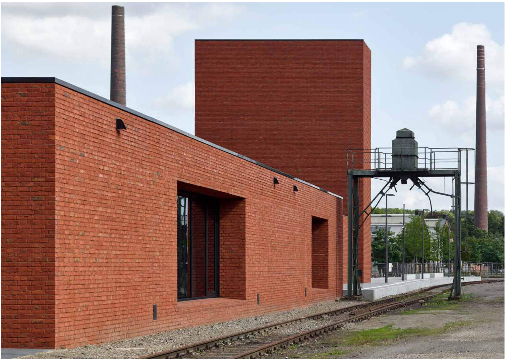
Der Entwurf setzt auf reduzierte Details und die Atmosphäre des Materials. In den Ziegelwänden des Baus verdichtet sich die industrielle Geschichte des Ortes.
