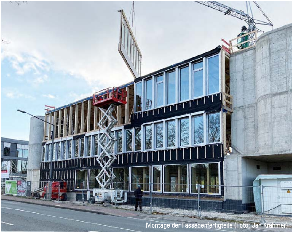
Montage der Fassadenfertigteile (Foto: Jan Krahmer)
