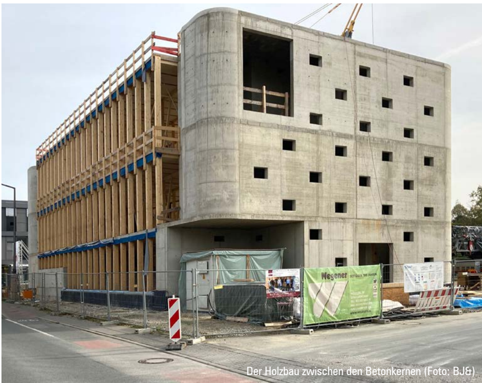
Der Holzbau zwischen den Betonkernen (Foto: BJ&)
