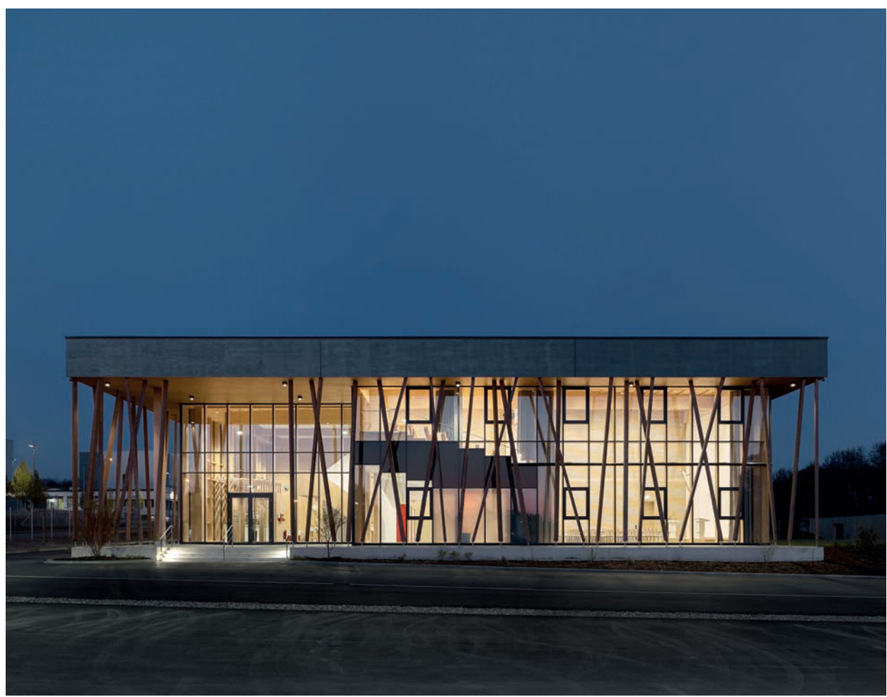
Westfassade mit Eingang
