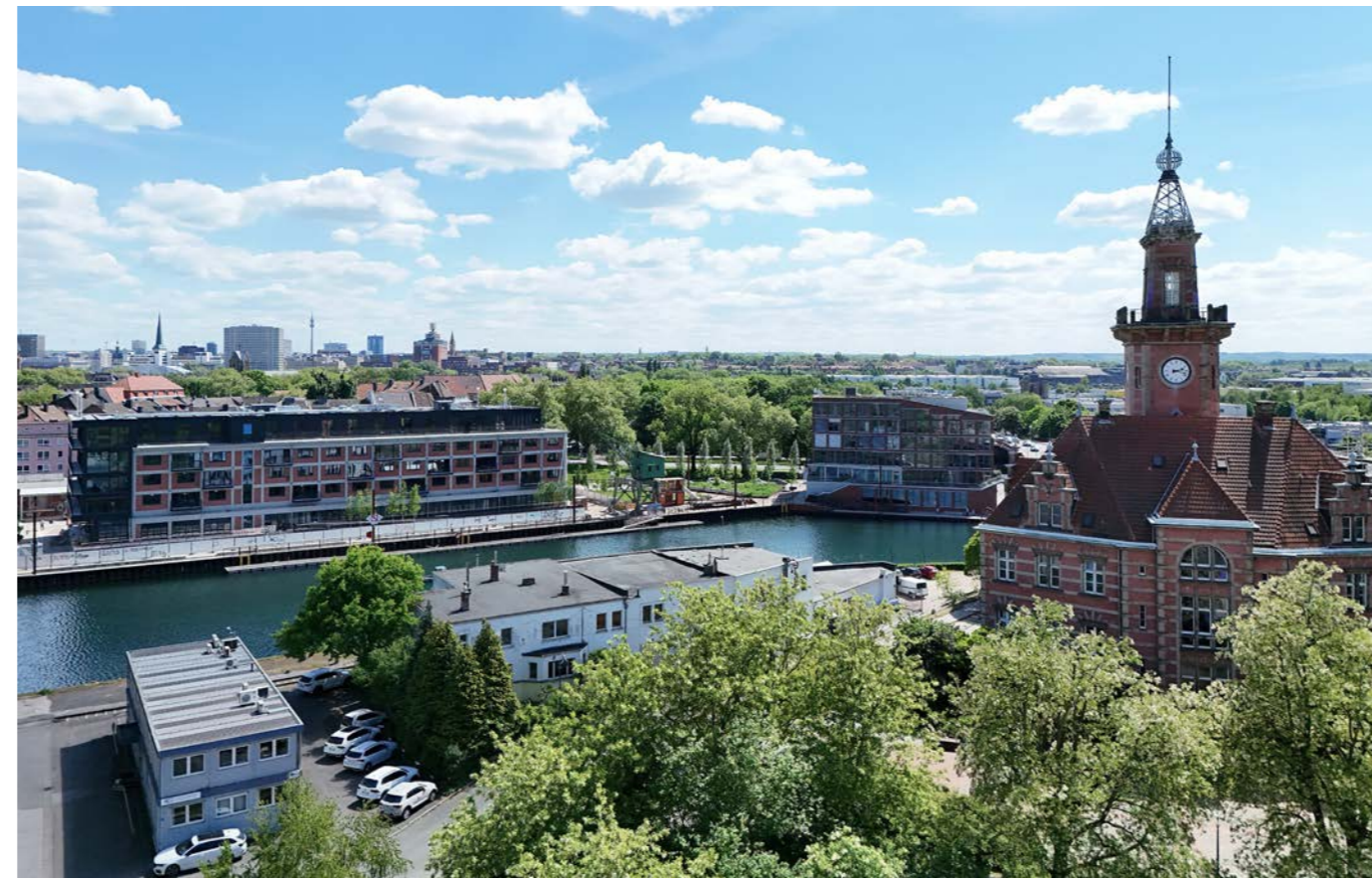
Blick auf das alte Hafentamt und den Dortmund-Ems-Kanal
