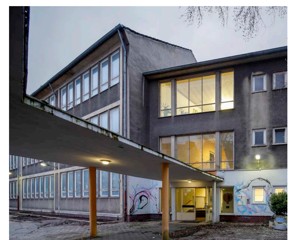
HAUPTINGANG VOR DEM UMBAU
