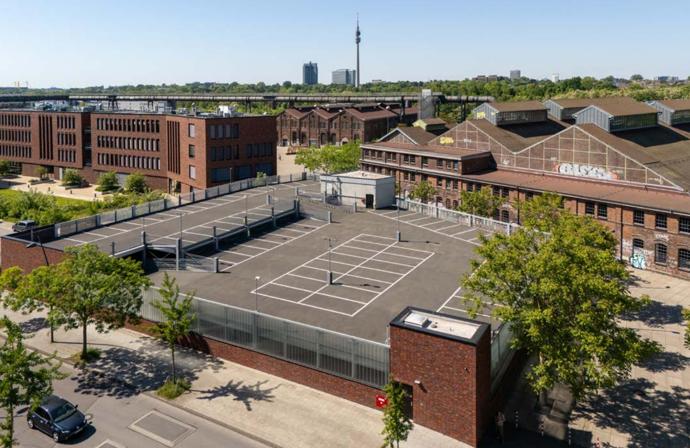
Parkgarage des PhoenixWERKS
