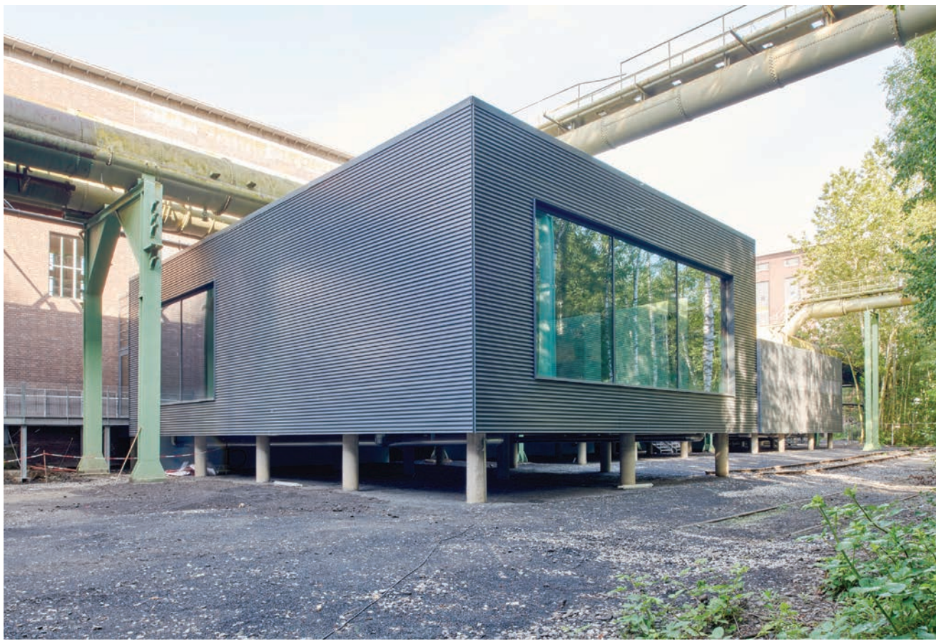
Aufgeständerte Erweiterung Salzlager
