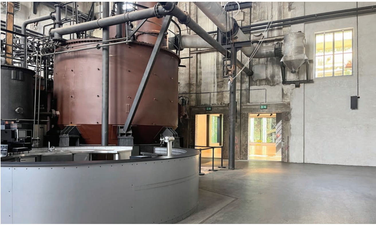
Foyer Salzfabrik mit Durchgang zum Anbau
