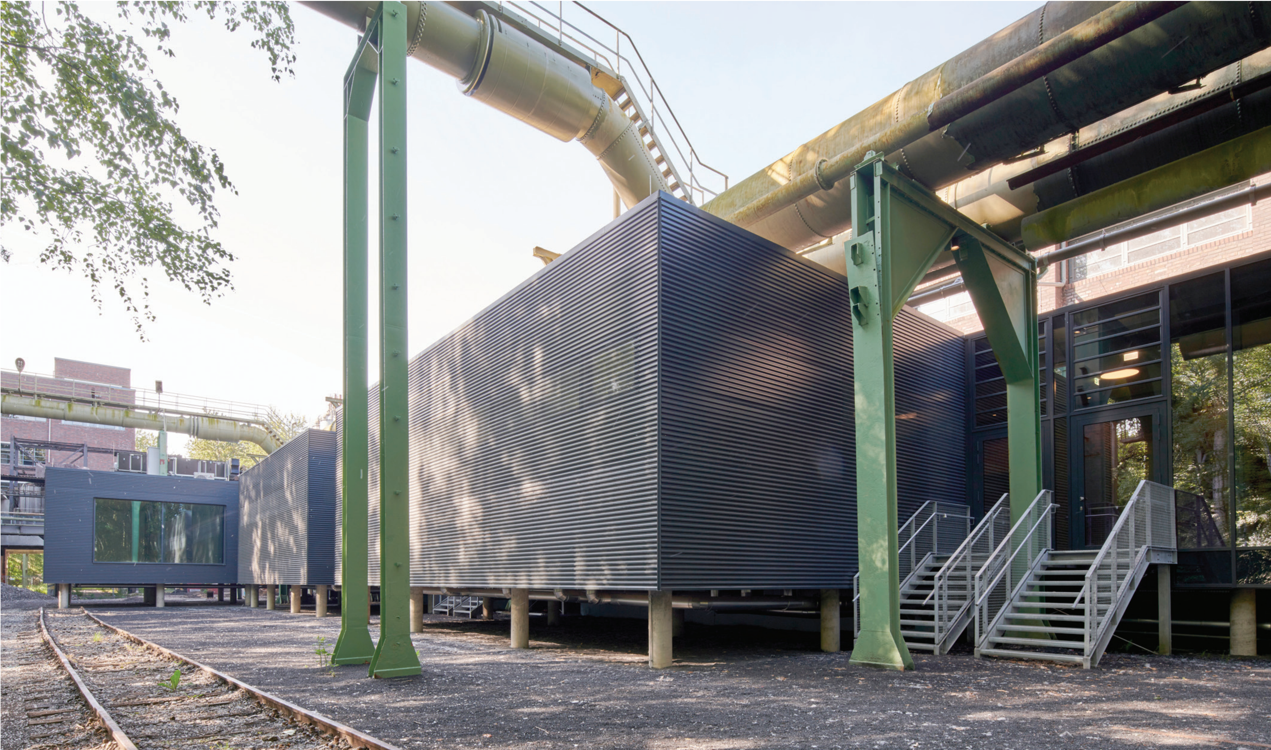
Erweiterungsbau Salzlager mit vorgehängter Trapezblechfassade
