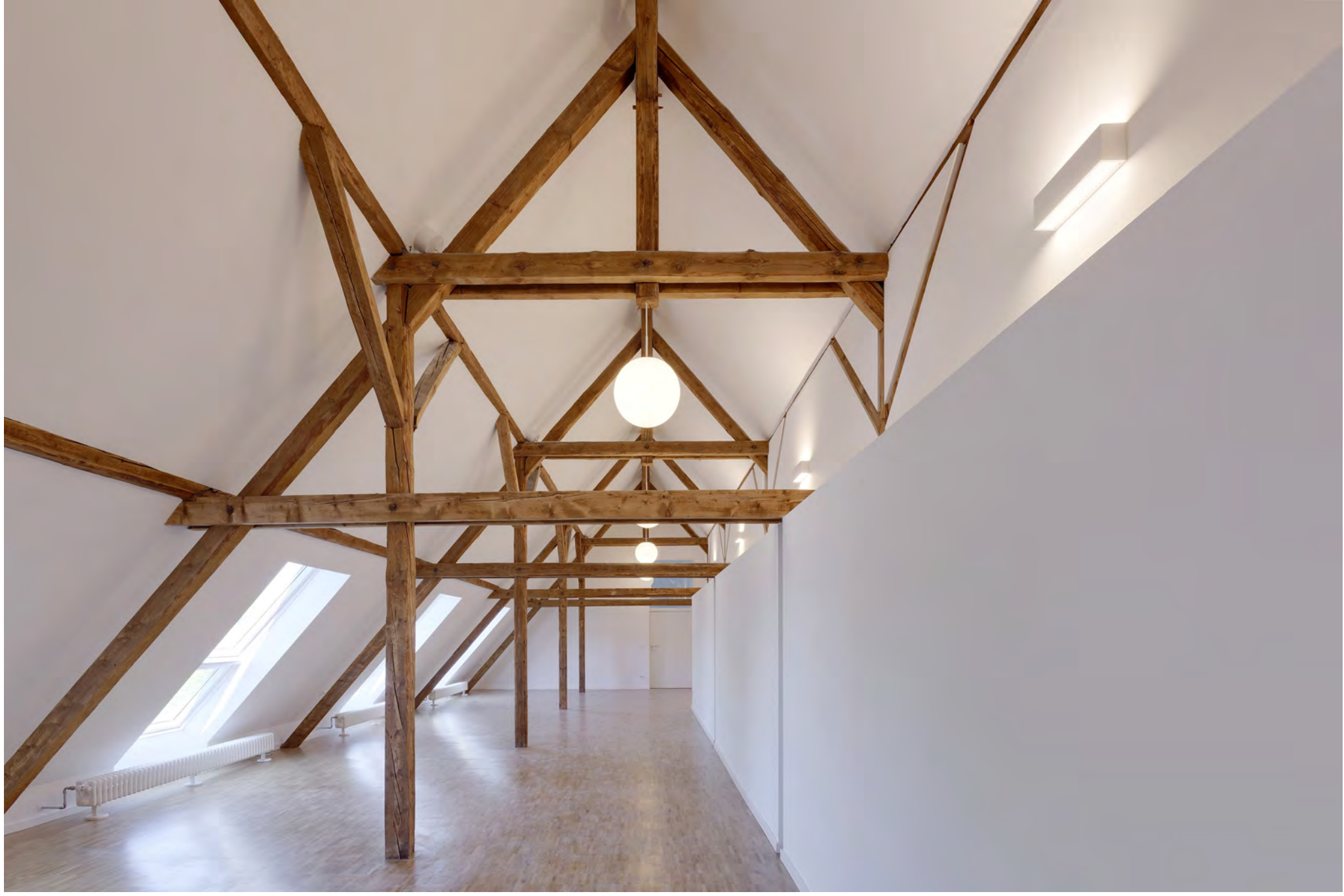
Dachgeschossausbau mit 2 Appartements und Spielbereich
