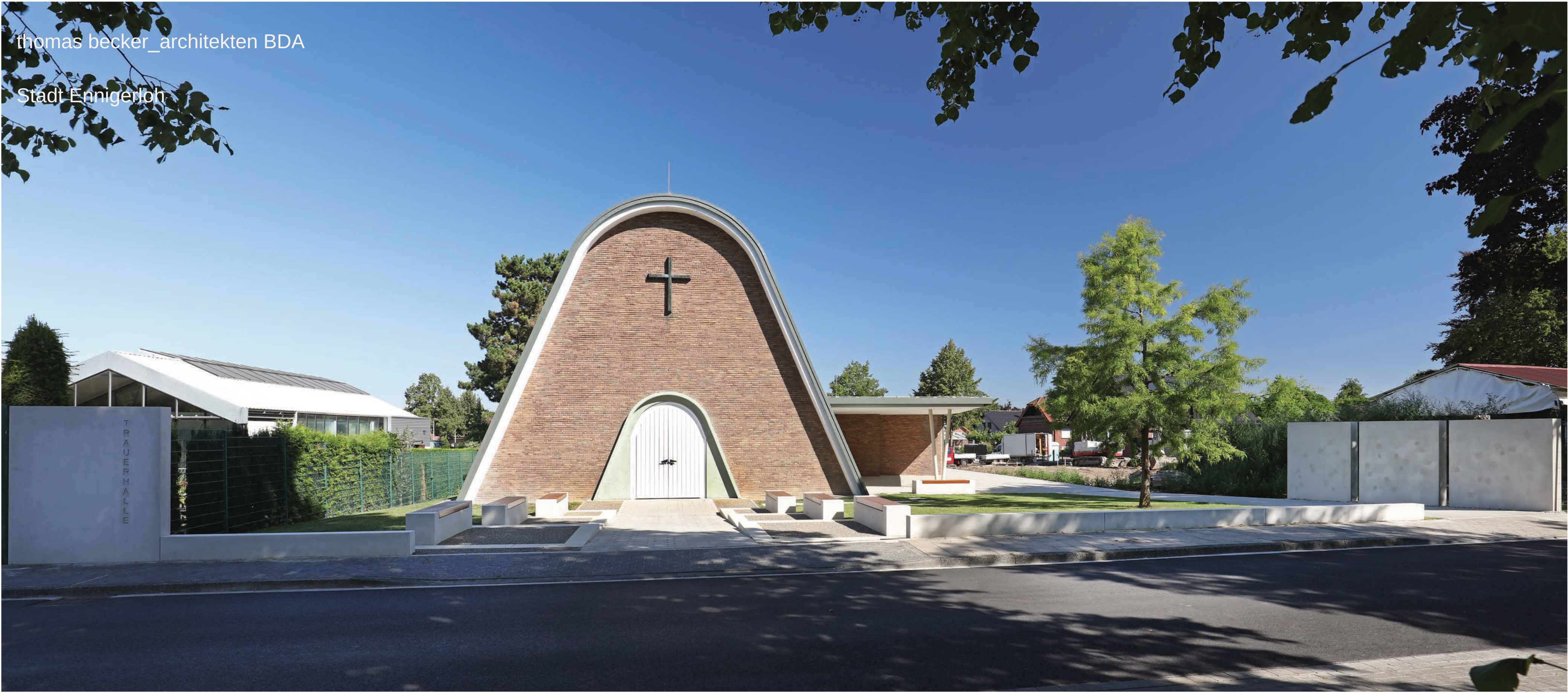
Trauerhalle mit Aussenanlagen
