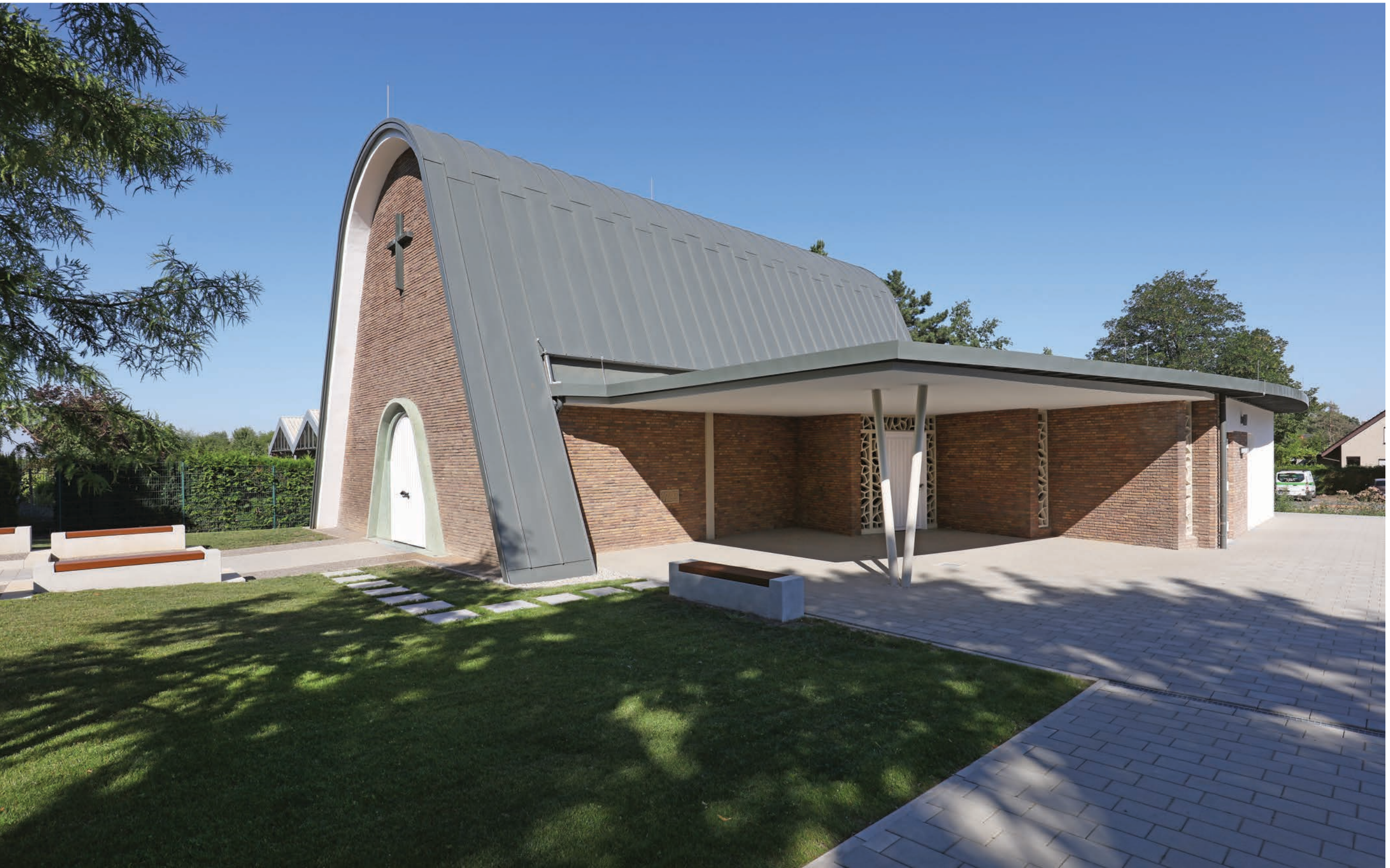
Blick auf das Vordach mit dem Seiteneingang
