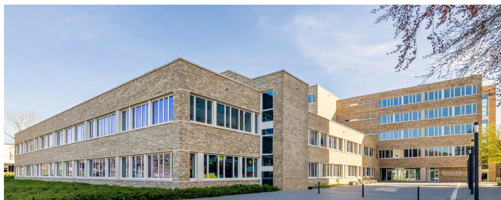
Nach der energetischen Sanierung: Bestandsgebäude 1976
