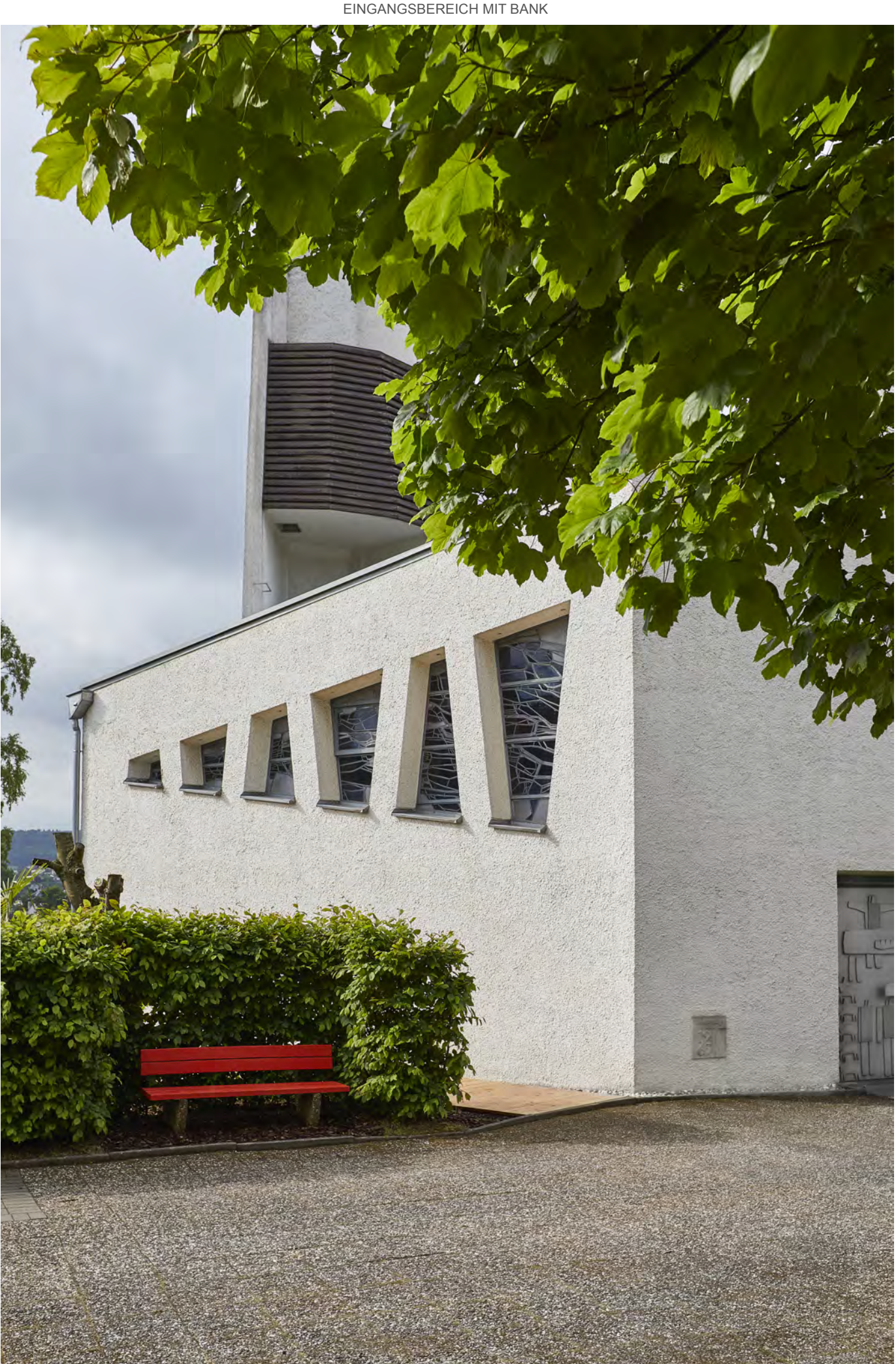
EINGANGSBEREICH MIT BANK
