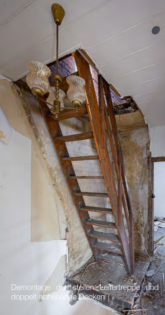
Freigelegte Oberflächen im Bestandsgebäude: Abbau der Backstein-Ausfachungen, Demontage der beschädigten und teilweise mit Schadstoffen behandelten Hölzer (leider!) und dadurch gewonnene Einblicke in die räumliche Tiefe.
