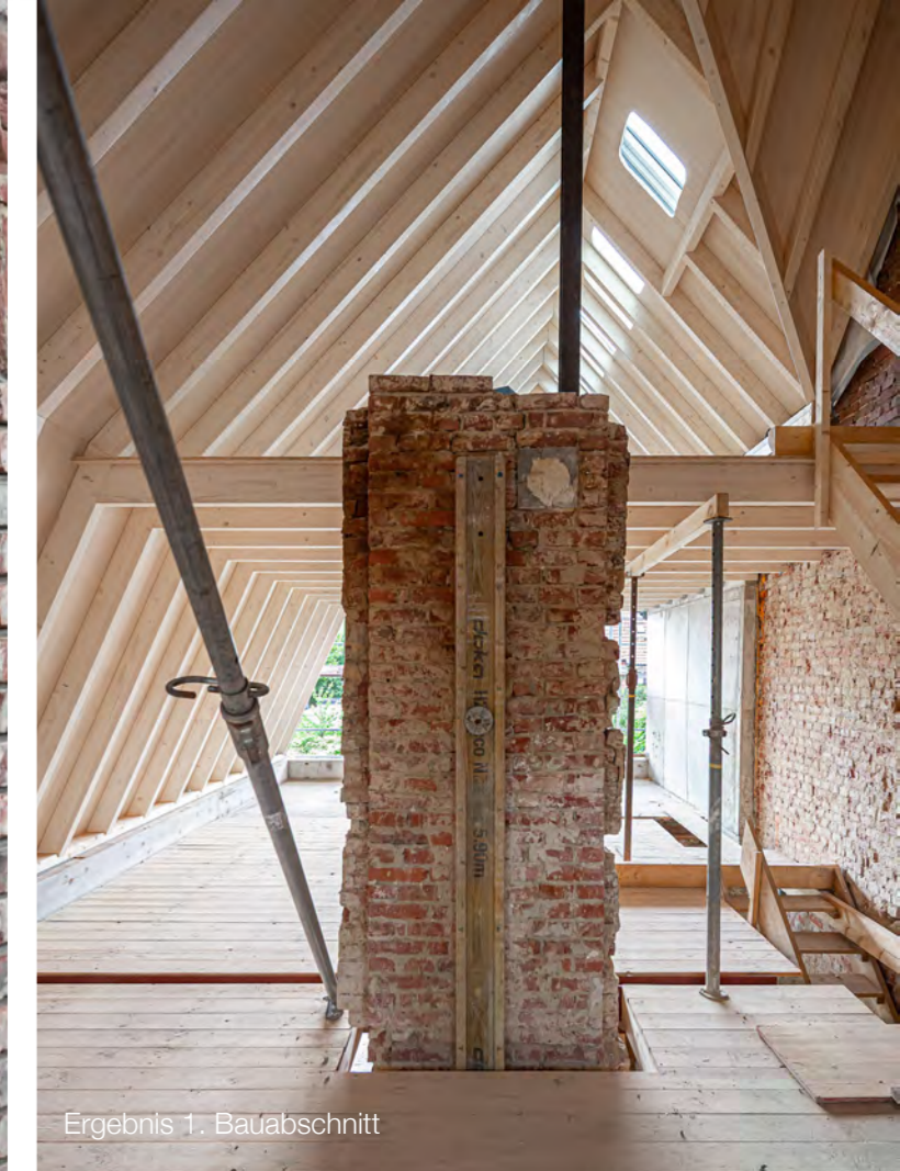
Die tragenden Ziegel des Bestands sind erhalten worden, nichttragenden Ziegeln der neuen Intentionen zu unterscheiden, insbesondere durch den Verbund.
