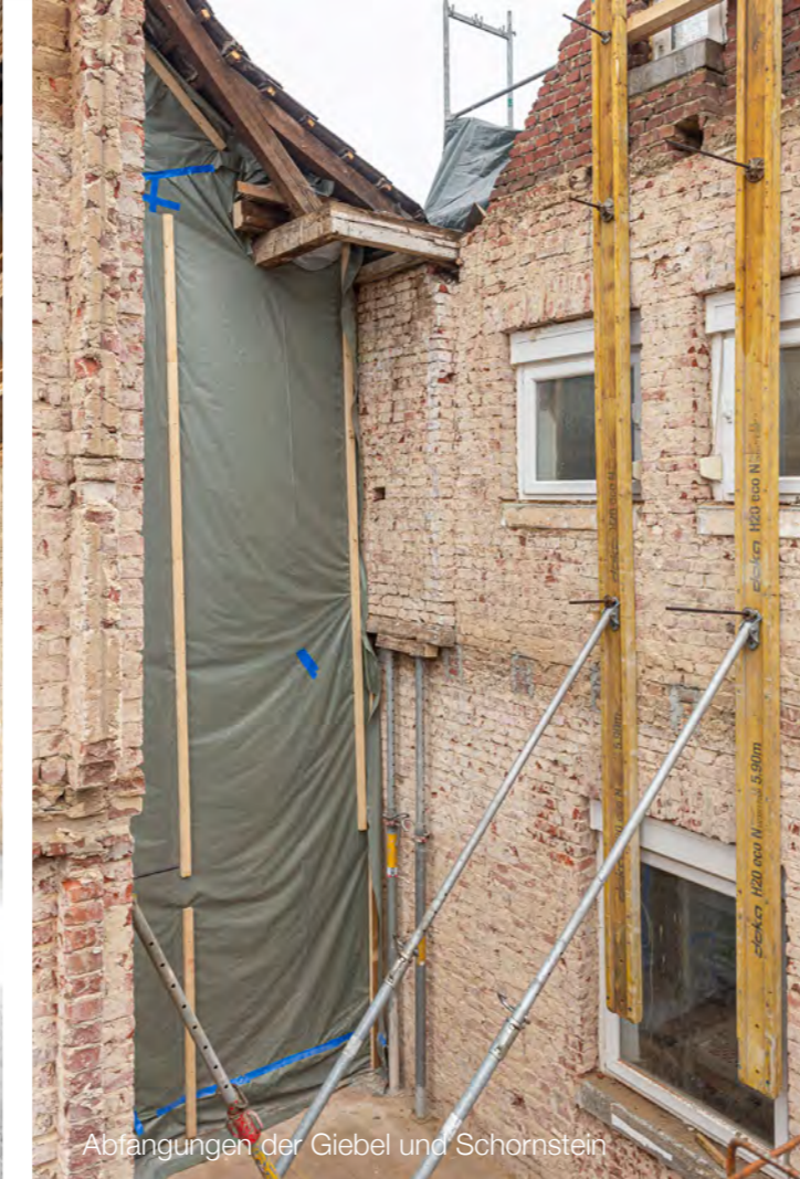
Freigelegte Oberflächen im Bestandsgebäude: Abbau der Backstein-Ausfachungen, Demontage der beschädigten und teilweise mit Schadstoffen behandelten Hölzer (leider!) und dadurch gewonnene Einblicke in die räumliche Tiefe.
