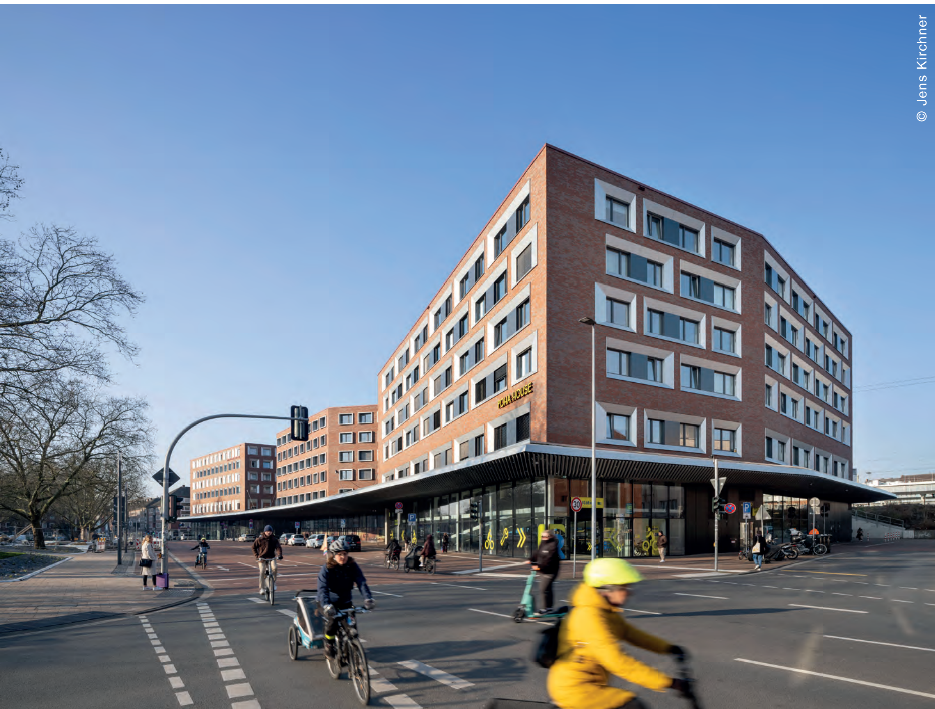
Eine Fahrradstation bietet 2.150 Stellplätze sowie Leih- und Reparaturservice auf drei Ebenen.
