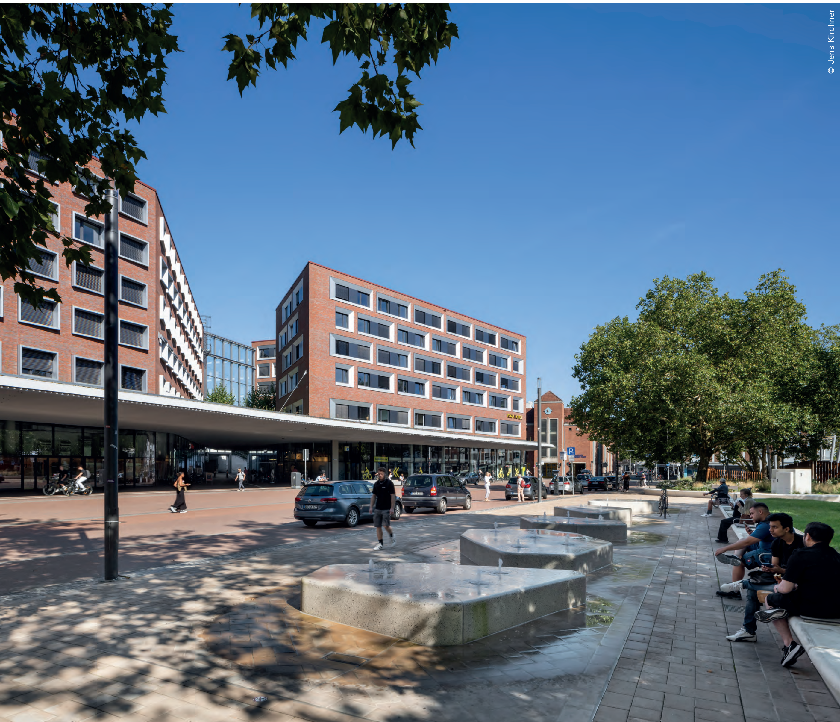
Der Neubau schafft einen einladenden Zugang zum Bahnhof.
