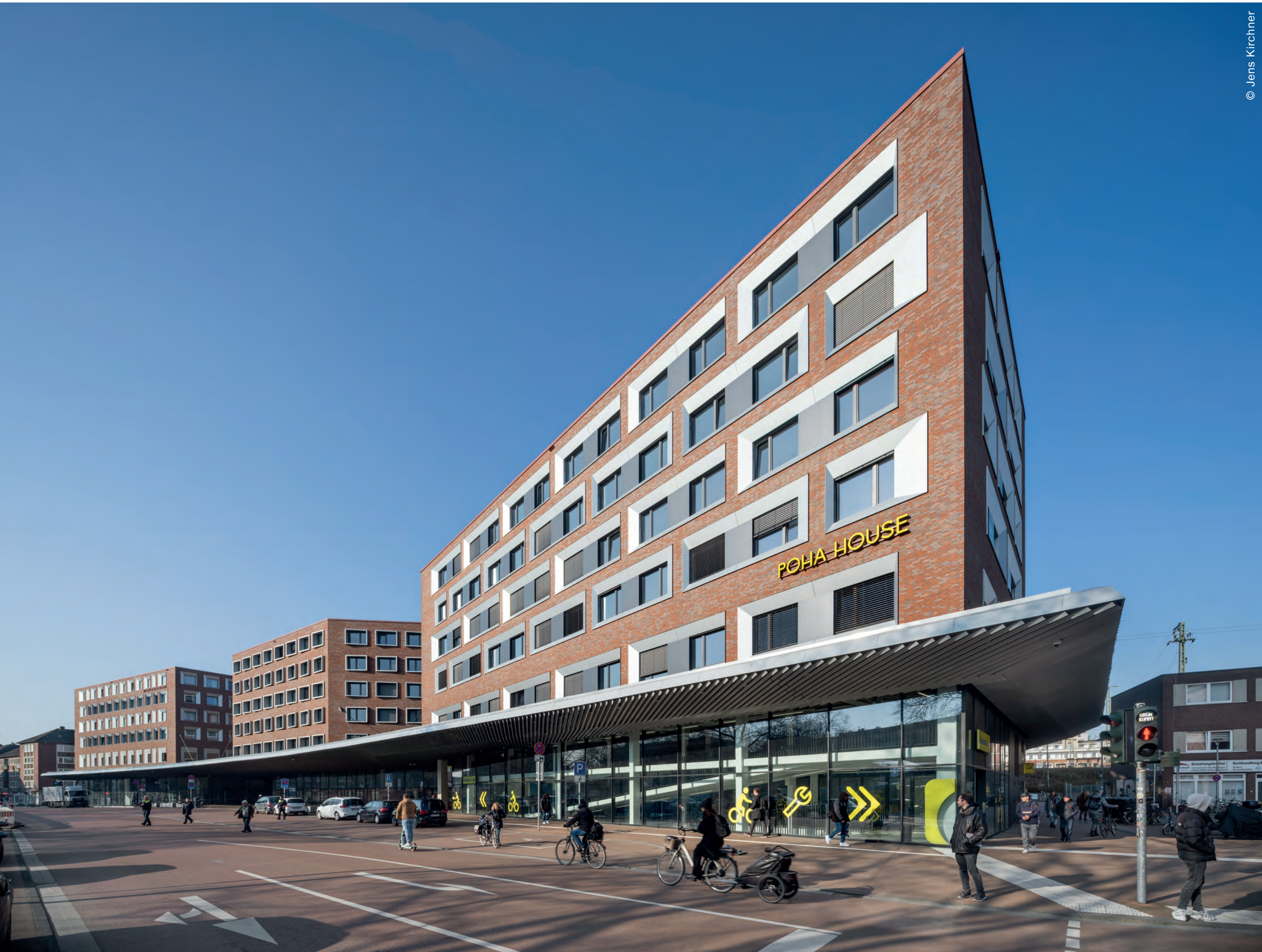
Das Gebäude ist in eine transparente, öffentlich-gewerbliche Erdgeschosszone, ein markant auskragendes, begrüntes Dach und drei darauf ruhende Baukörper gegliedert.
