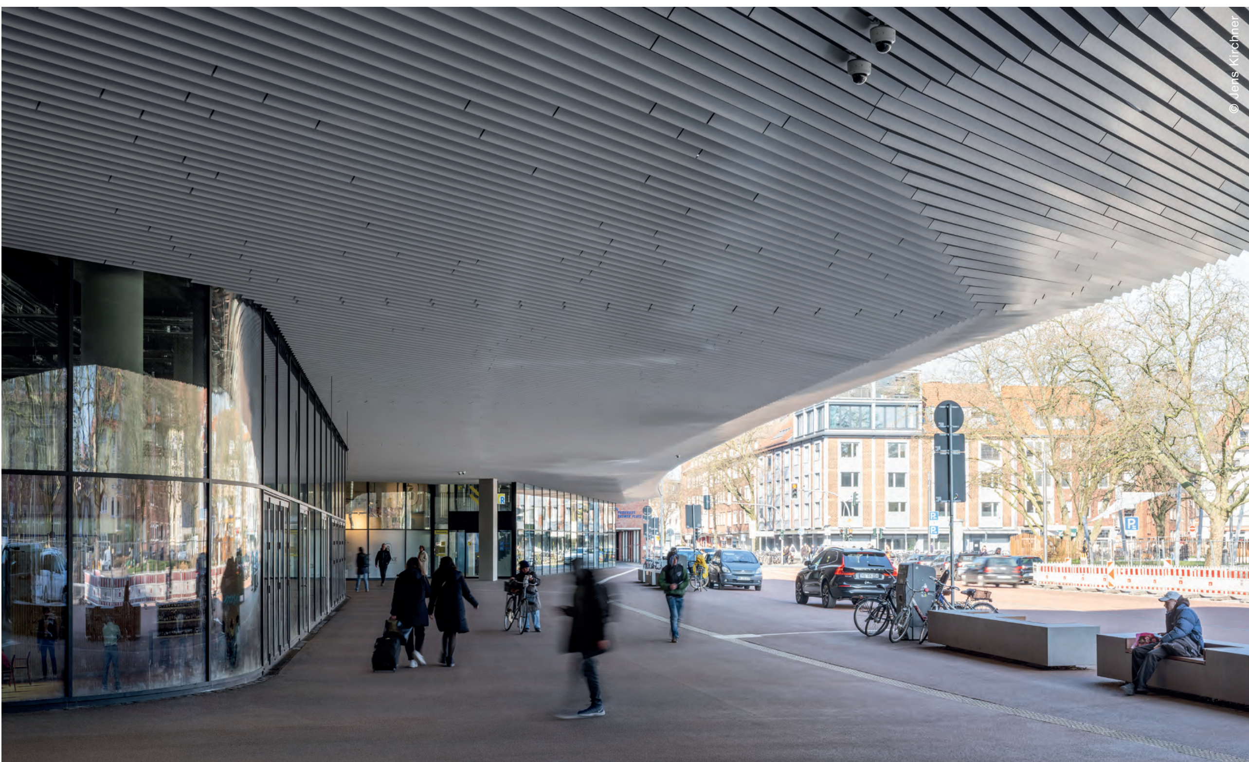
Der öffentliche Raum wird im Erdgeschoss, flankiert von Läden und Gastronomie, trichterförmig bis zu den Gleiszugängen auf der Rückseite ins Gebäude hineingeführt.
