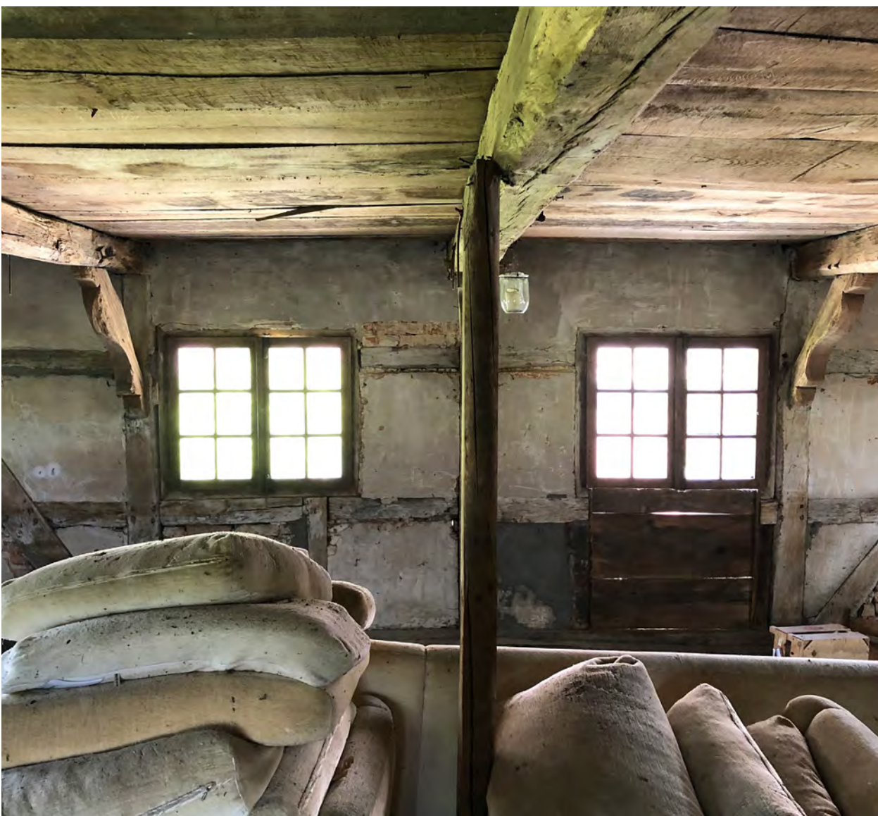
Obergeschoss vor dem Umbau
