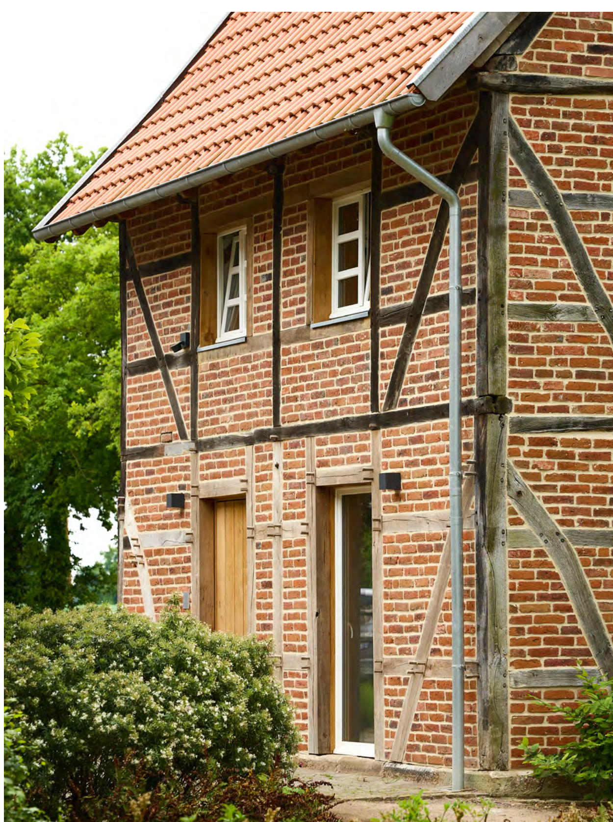
Eingang zum Speicher
