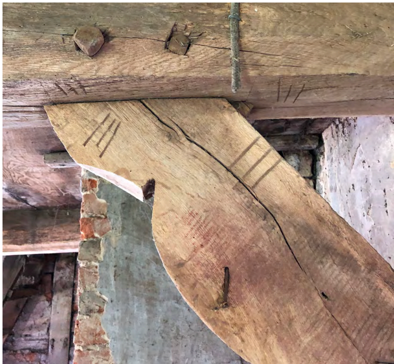
Holzverbindung im Inneren vor dem Umbau
