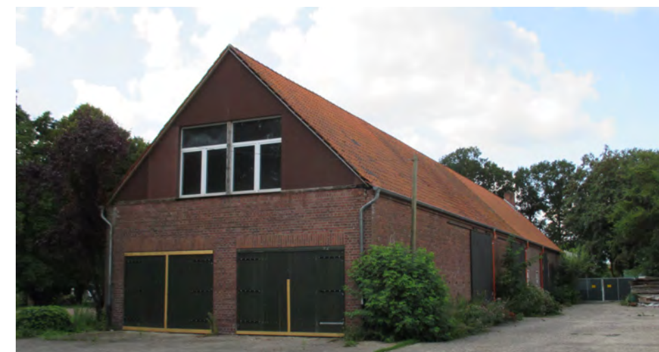
Vorher: Die Scheune wurde als Lager- und Stallgebäude genutzt.
