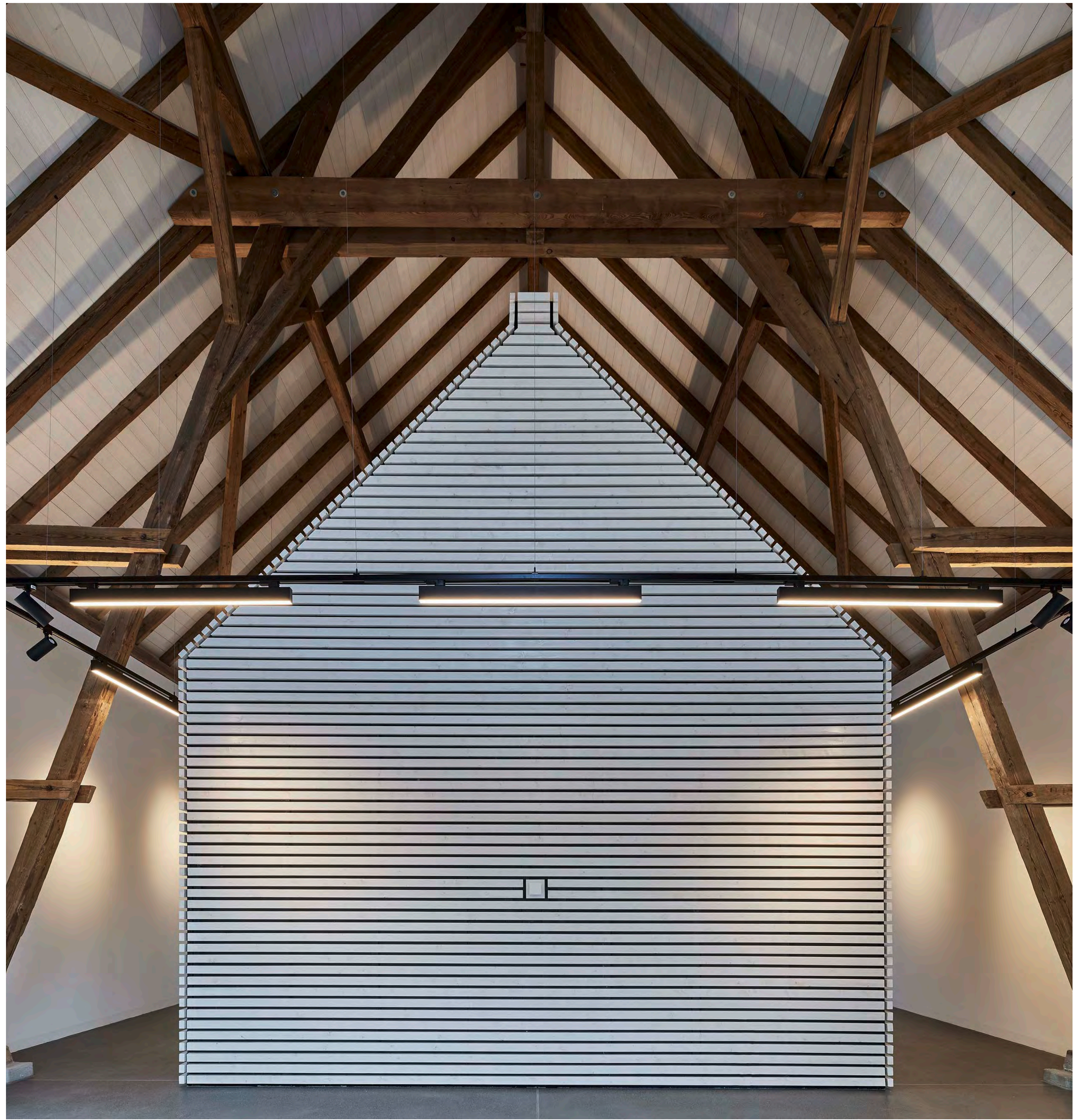
Der Veranstaltungsraum ist nach dem Haus-in-Haus-Prinzip in das Gebäudevolumen eingestellt.
