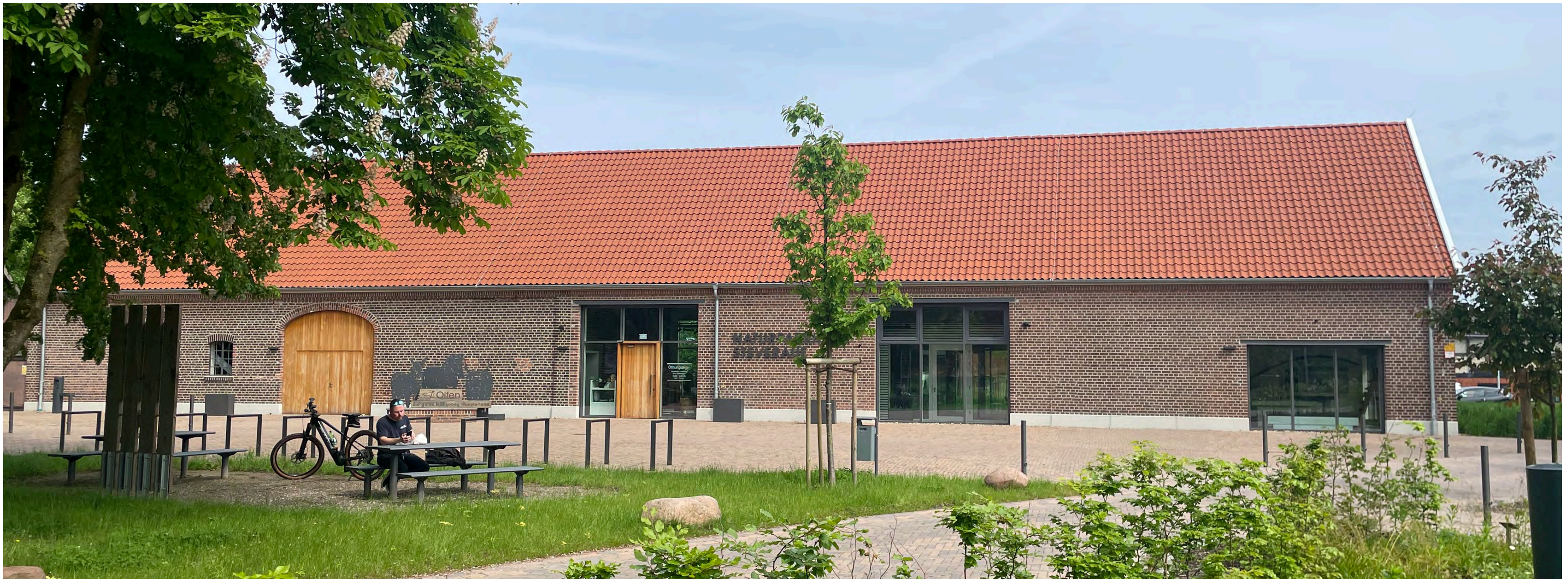
Die ehemalige Scheune an der Füchtelner Mühle in Olfen wurde durch die Sanierung und Umgestaltung zum neuen Tourismus- und Informationszentrum „Naturparkhaus Steveraue“ qualifiziert. Sie ist ein beliebtes Ausflugsziel im Naturpark Hohe Mark.
