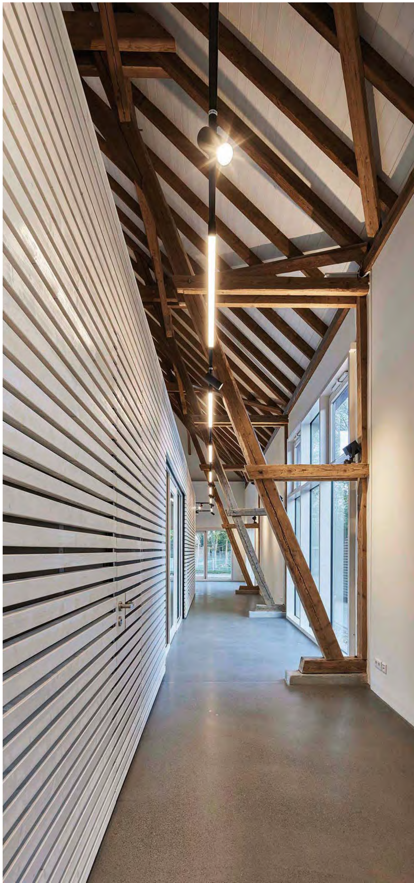
Das historische Tragwerk und der Dachstuhl wurden vollständig erhalten.
