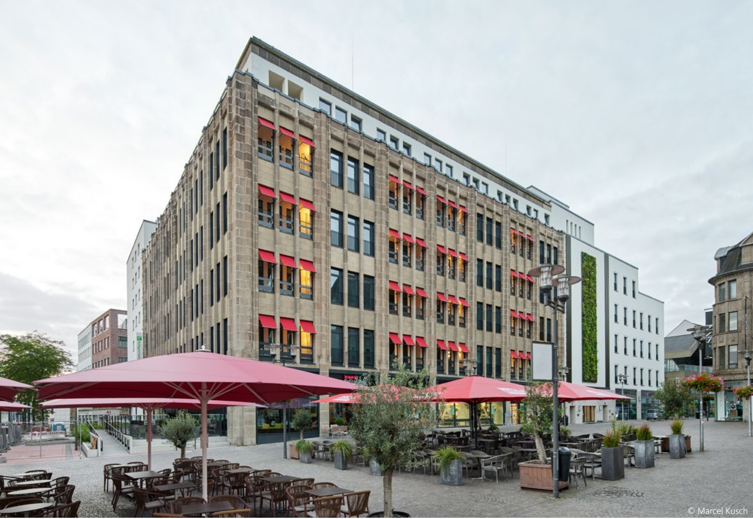
Bestandsgebäude des ehemaligen Karstadt mit Gastronomie und Nahversorgung im Erdgeschoss und Servicewohnen in den Obergeschossen. Loggien mit roten Markisen werben die Atmosphäre am Marktplatz weiter auf.
