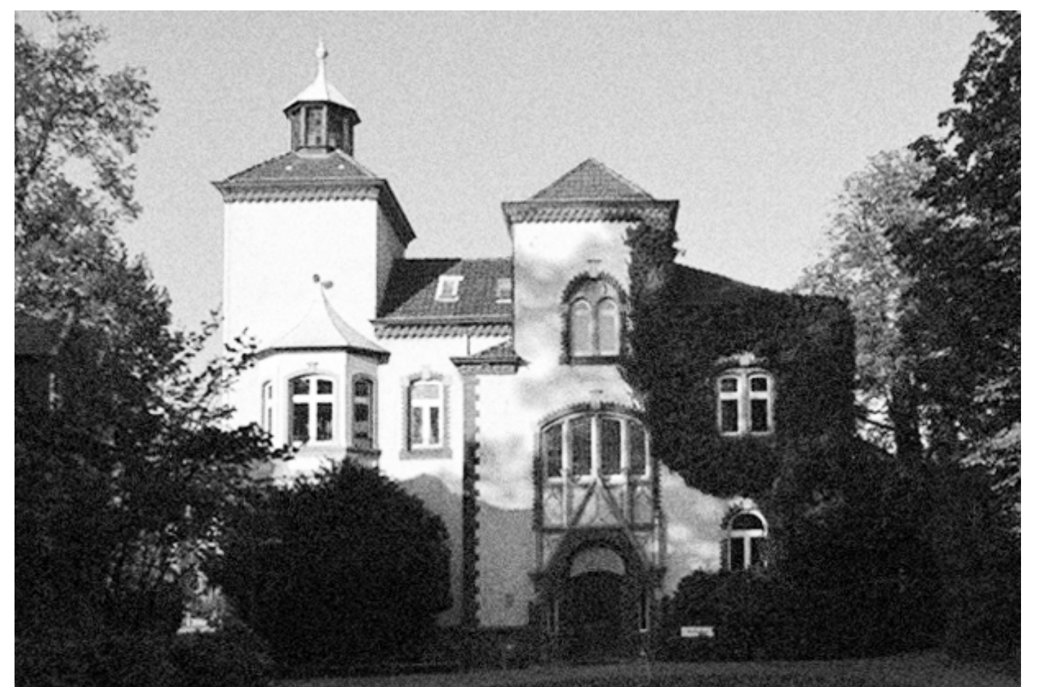
Landratsvilla Recklinghausen vor der Erweiterung und Sanierung
