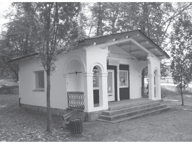
Bestandsituation des Prinzenhauses im Jahr 2023
