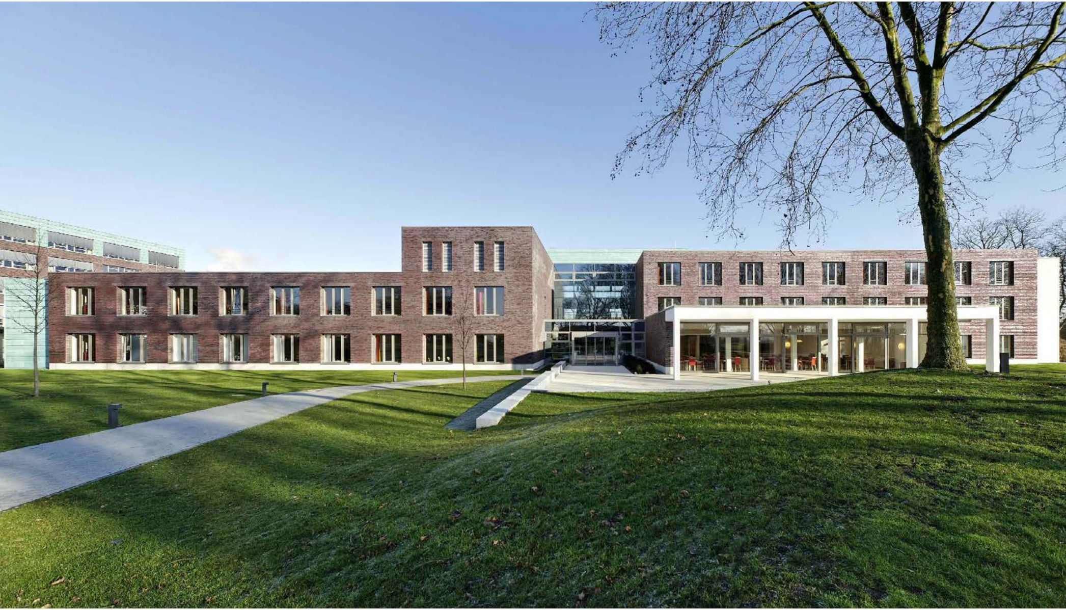
Westfassade Reha-Klinik mit Anschluss an Parkflügel
