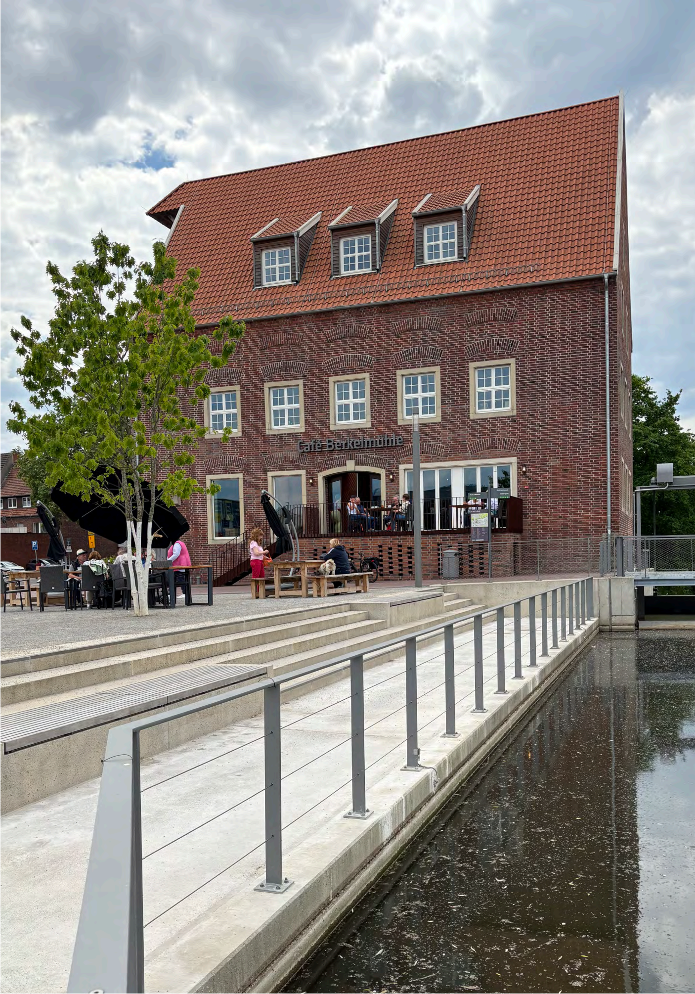
Der Platz orientiert sich mit einer Treppenanlage zum Fluss oberhalb des Wehrs; stellt so einen intensiven Bezug zur Berkel her.
