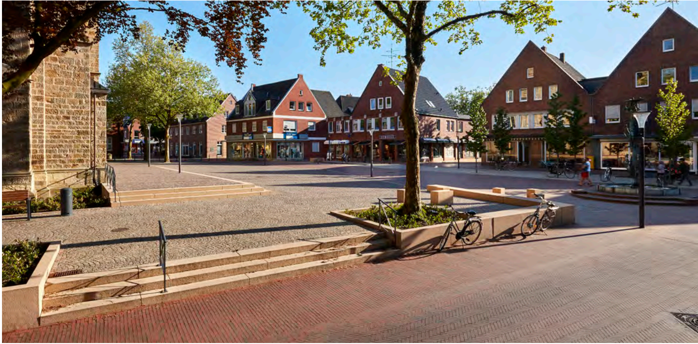
Der Platzraum öffnet sich nach Norden zur Dufkampstraße und schafft so die wichtige Vernetzung beider Stadträume; der Rückbau der großen Treppenanlage, eine neue Rampenanlage, taktiles Leitsystem und Gehband sorgen für Barrierefreiheit.
