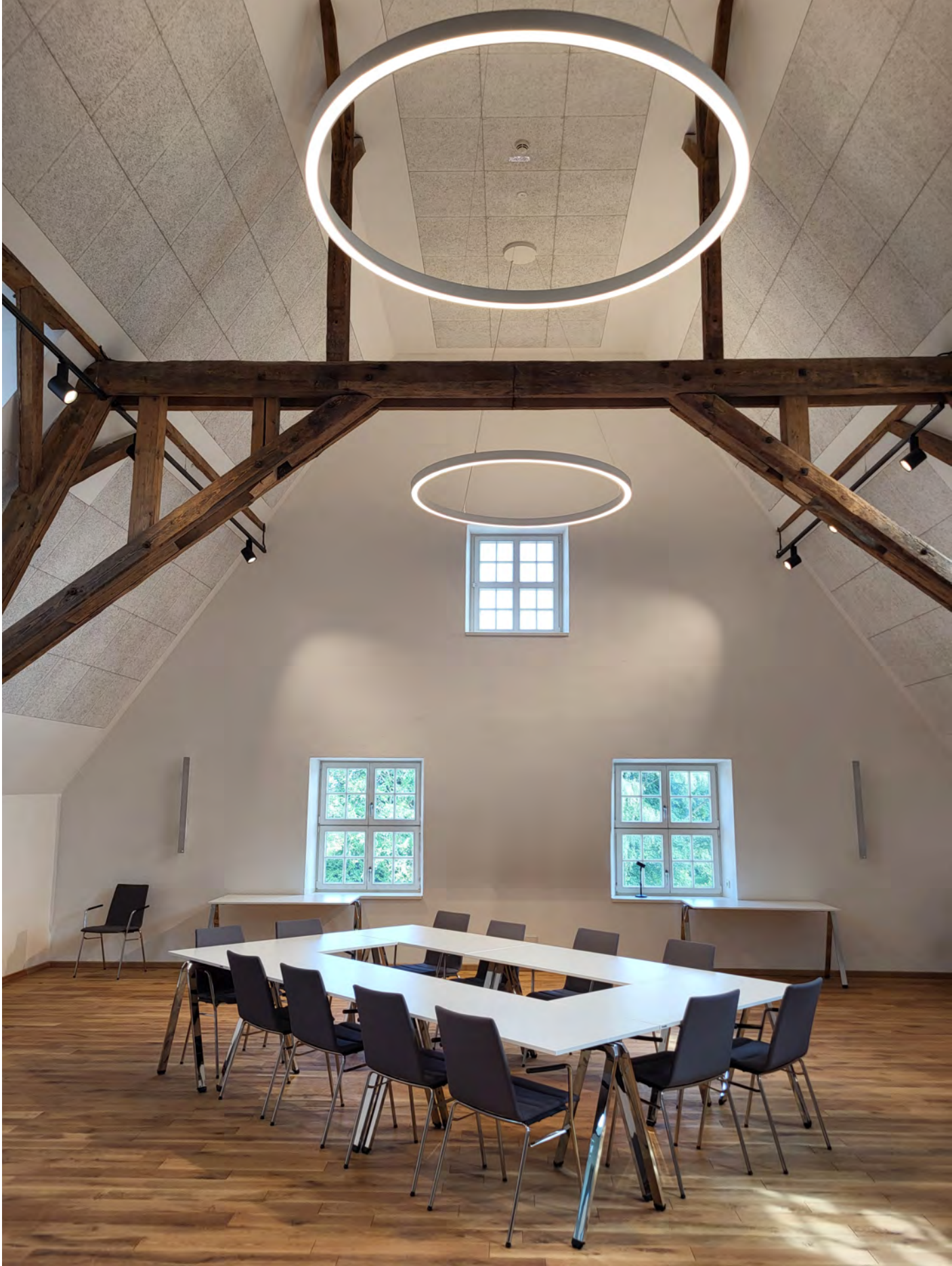
Der multifunktionale Mühlensaal im imposanten Dachgeschoss mit sichtbarem Sprengwerk.
