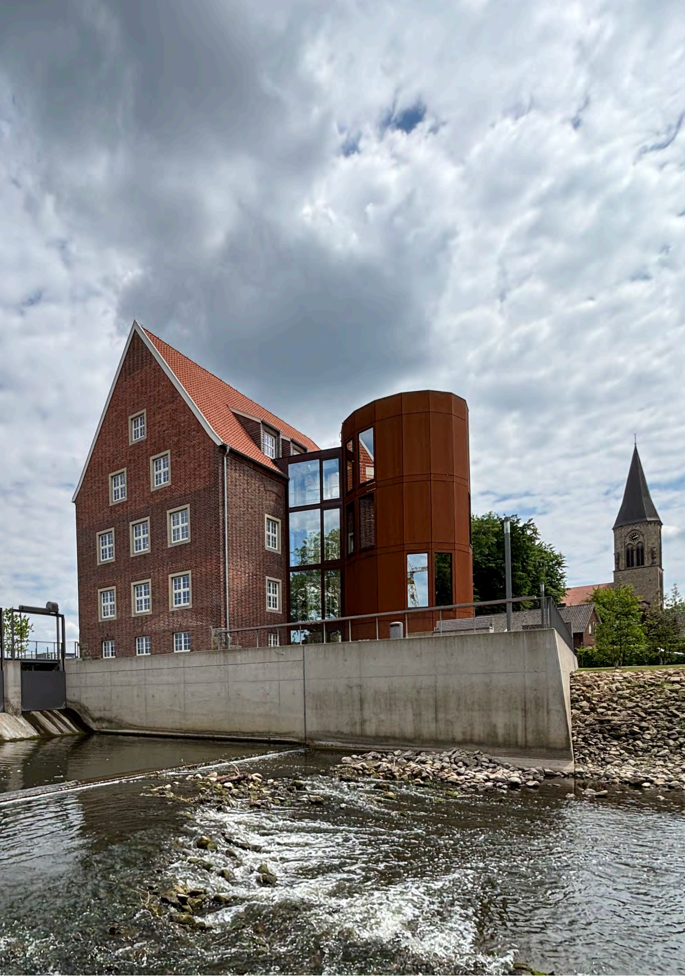
Blick auf Berkelmühle und St. Otger vom Berkelbalkon aus
