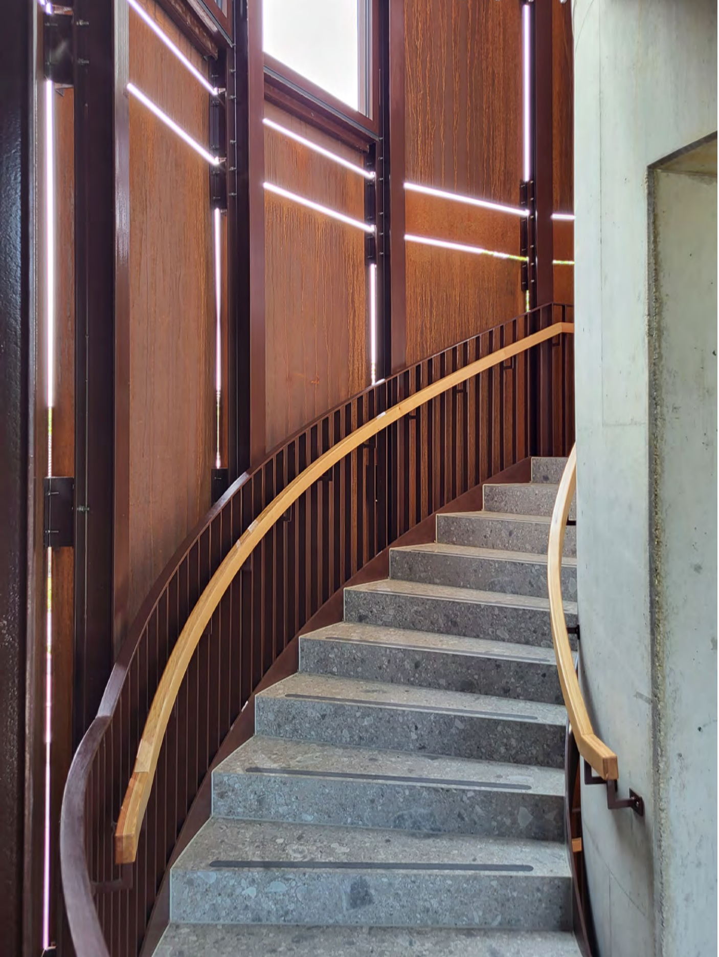
Architektonischer Blickfang in Corten-Stahl: Treppenturm mit Aufzug zur barrierefreien Erschließung der Berkelmühle.
