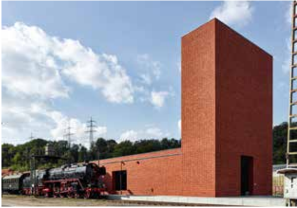
037 Bochum Empfangsgebäude Eisenbahnmuseum
