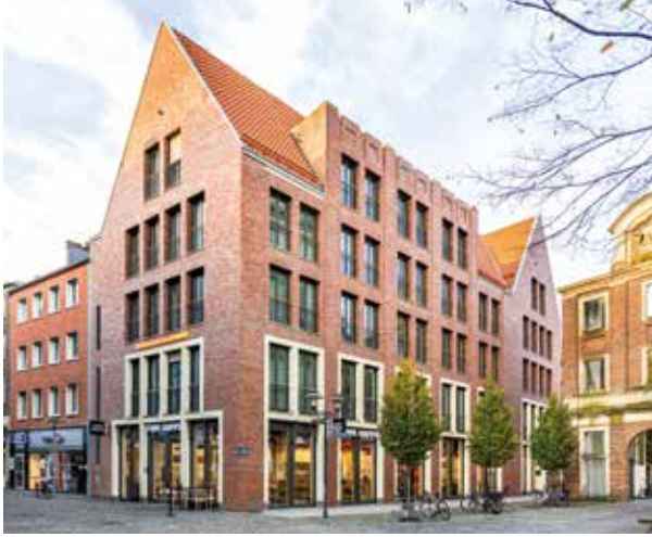
141 Münster Geschäftshaus Salzstraße 9
