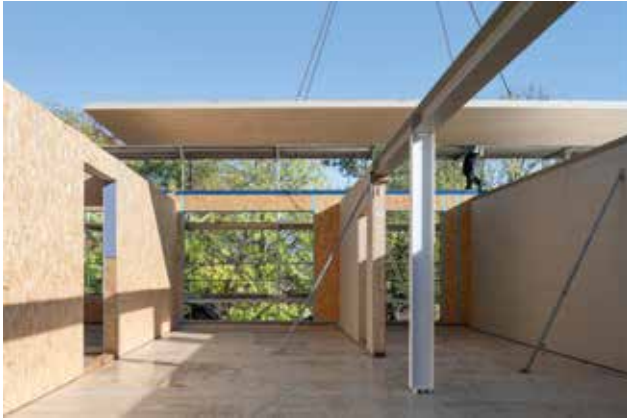
Die Holzbauweise mit einem hohen Grad an Vorfertigung ermöglichte eine schnelle und wirtschaftliche Errichtung. Fotos: Viola Epler Fotografie
