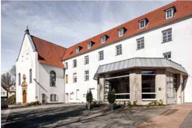
Vor Beginn des Umbaus diente das ehemalige Kloster jahrhundertlang als Krankenhaus. Der bauliche Zustand basierte auf dem Wiederaufbau nach dem Zweiten Weltkrieg. Foto: David Chipperfield Architects
