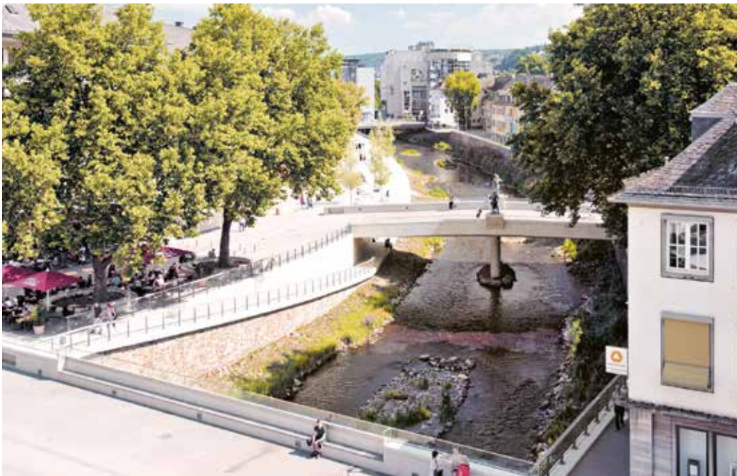
Brücken über die Sieg wurden saniert und neu geschaffen, um Wege- verbindungen aufrechtzuerhalten und zu stärken. Foto: Atelier Loidl
