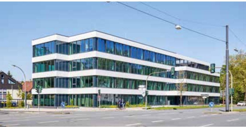
089 Herne Umbau eines Geschäftshauses zu einer Zahnklinik
