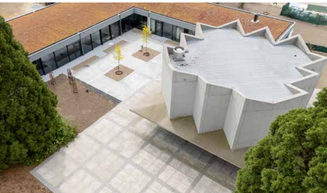
Die Betonoberflächen wurden behutsam saniert. Foto: lensit.photography
