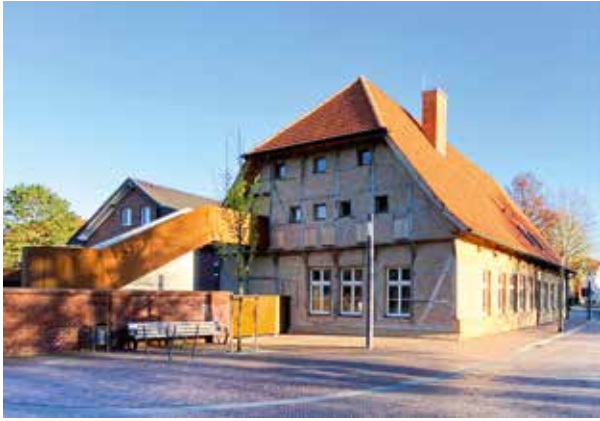
173 Senden Altes Zollhaus – Revitalisierung eines Baudenkmals
