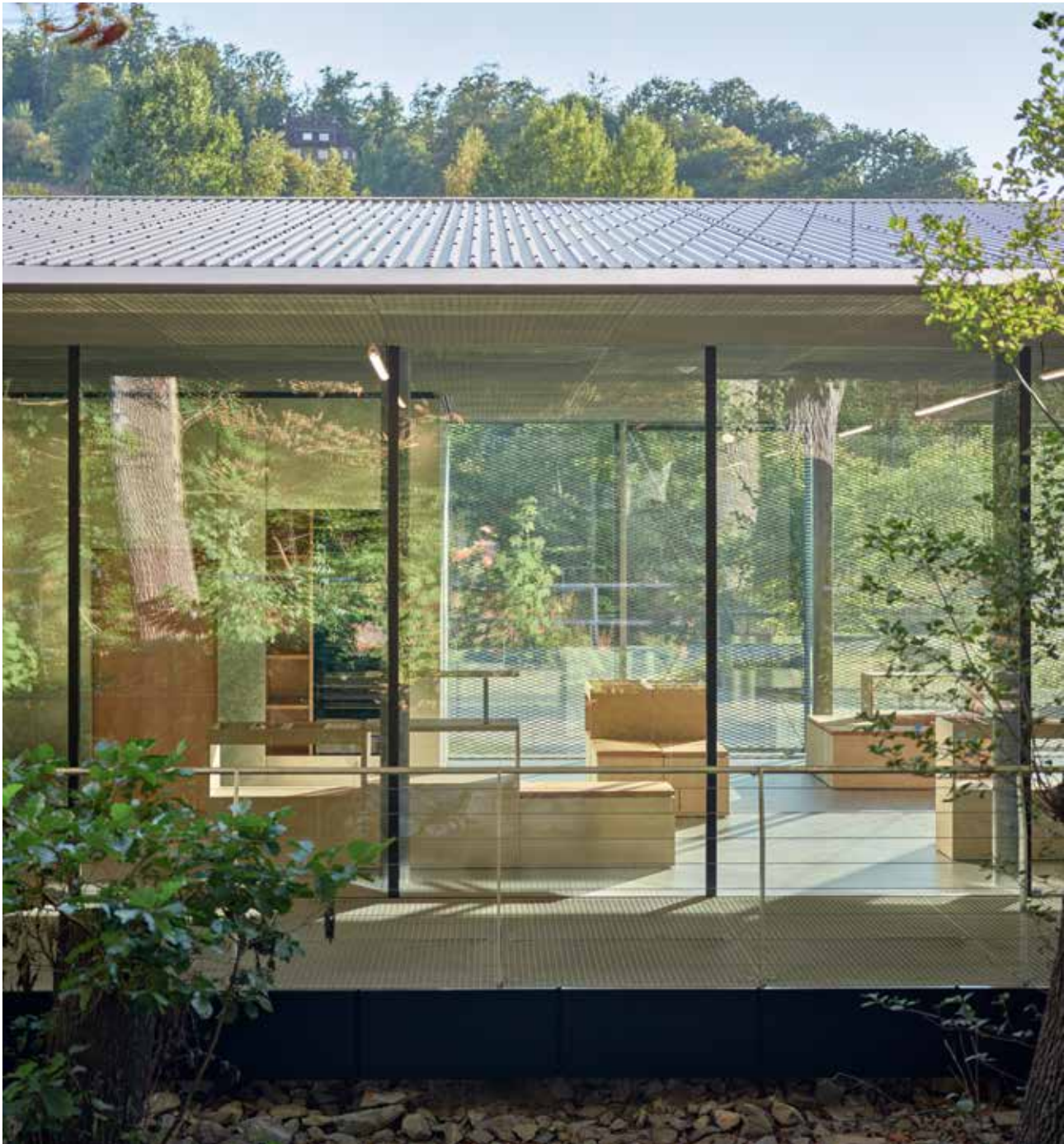
Das Gebäude ist auf den Lauf der Sonne während der Jahreszeiten ausgerichtet. Durch Dachüberstände und eine der Fassade vorgelagerte, netzartige Filterschicht wird es im Sommer verschattet und kann im Winter dennoch durch einfallendes Sonnenlicht erwärmt werden. Foto: Caspar Sessler
