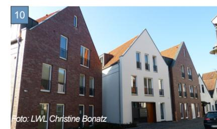
Das neue Gebäudeensemble besteht aus drei giebelständigen Gebäuden, die entlang der historischen Bauflucht zum Bütkamp stehen. Die Baukörper nehmen die Größenordnungen der umgebenden Bebauung auf. Die Fassaden sind als Lochfassaden mit ruhiger Anordnung der Öffnungen gestaltet. Das wechselnde Fassadenmaterial von Putz und Ziegel orientiert sich an den traditionellen Materialien im historischen Stadtkern. Alle Balkone und Terrassen sind zum Hof ausgerichtet.
