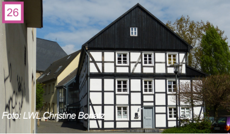
Umbau eines Fachwerkgebäudes (D), Krummfuß 12, Kissing Architekten, Iserlohn
